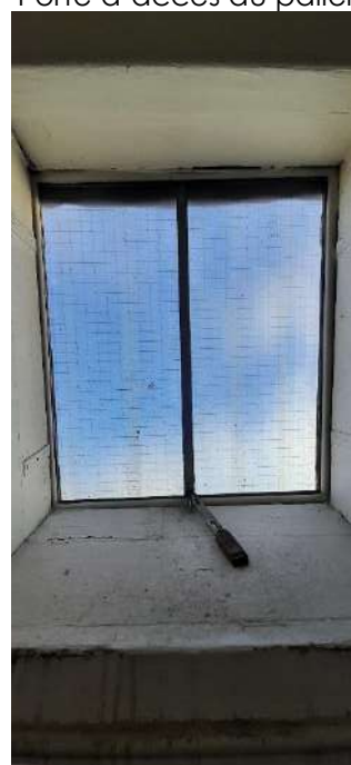
Fenêtre de toit du R+6
