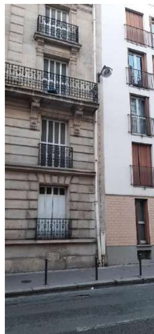
Descente EP en façade
