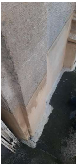
Reprises visibles de l'étanchéité des balcons du R+2
