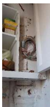
Descente EV fonte remplacée
