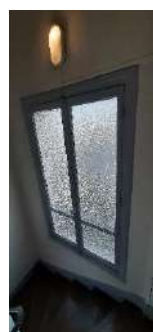
Menuiserie des cages d'escalier
