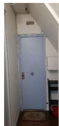
Revêtement de la circulation
