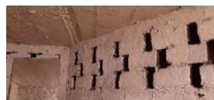
Cloison des caves en brique
