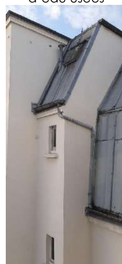
Mur sur WC, possiblement en pan de bois
