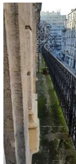
Développement de mousse sur les balcons
