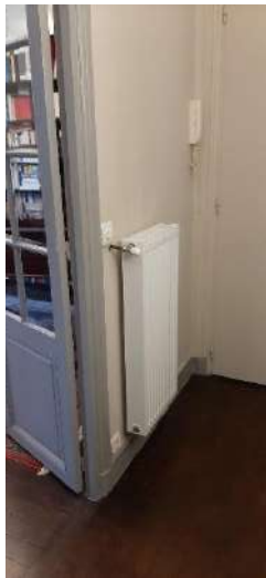
Radiateurs à eau chaude remplacé
