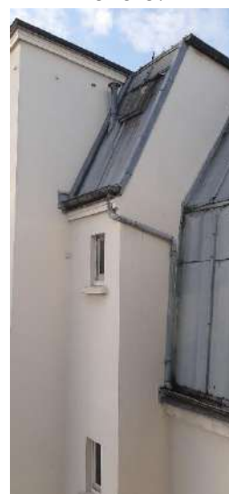
Mur brisis R+6 côté cour
