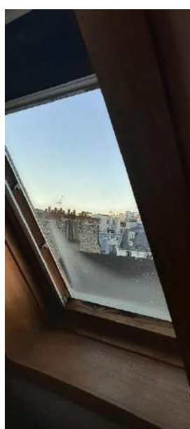
Fenêtre de toit double vitrage ancien en bois
