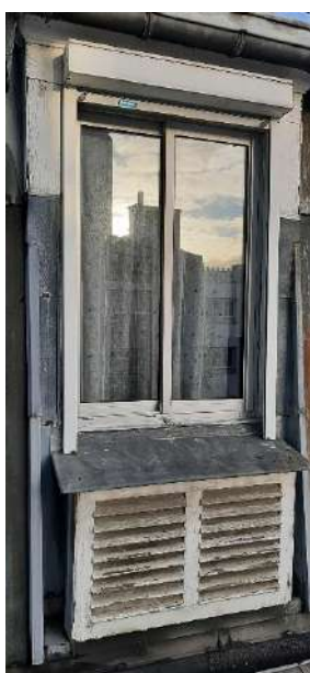
Menuiserie double vitrage ancien en alu avec volets roulants
