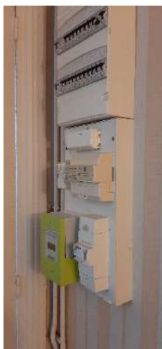
Compteur électrique individuel et tableau électrique en logement
