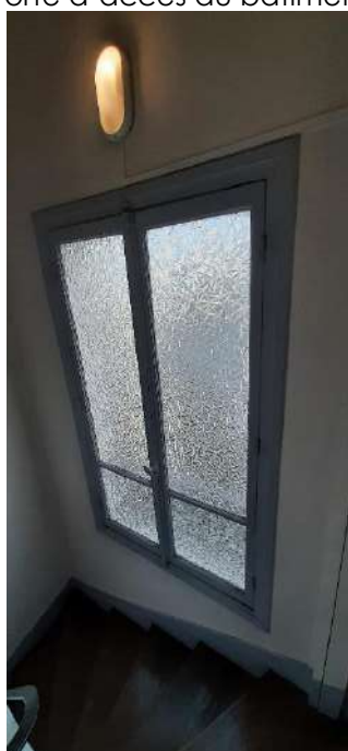
Menuiserie simple vitrage bois
