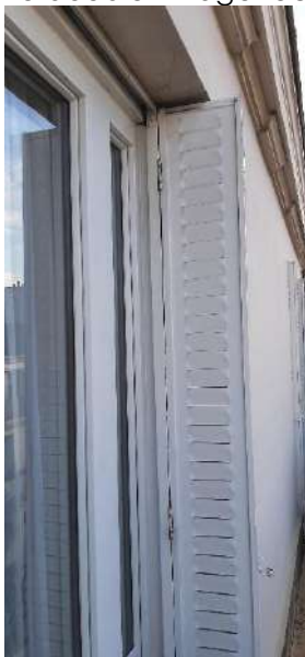
Persiennes métalliques au R+5 côté rue
