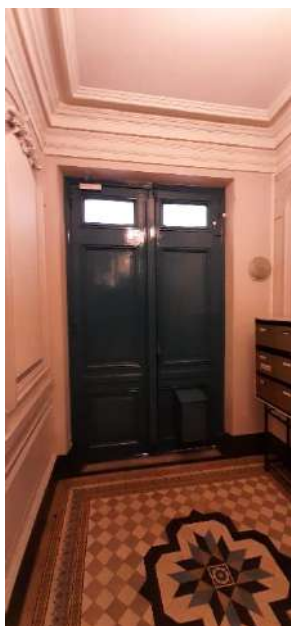
Porte d'accès au bâtiment
