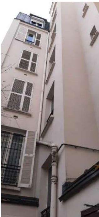
Descente EP en façade cour
