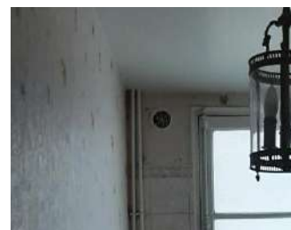
Sortie d'air en façade
