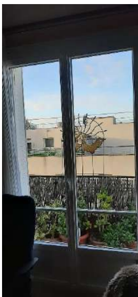
Menuiserie double vitrage récent PVC
